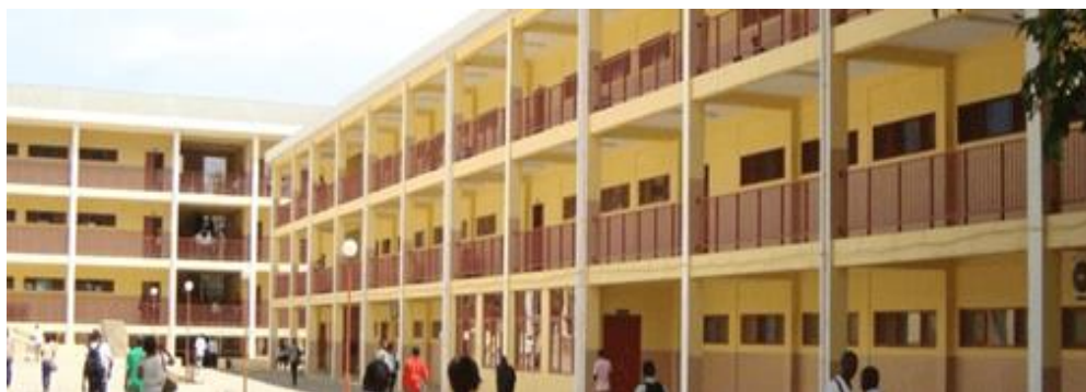
Figura 46: UniRovuma ( campus de Napipine)
